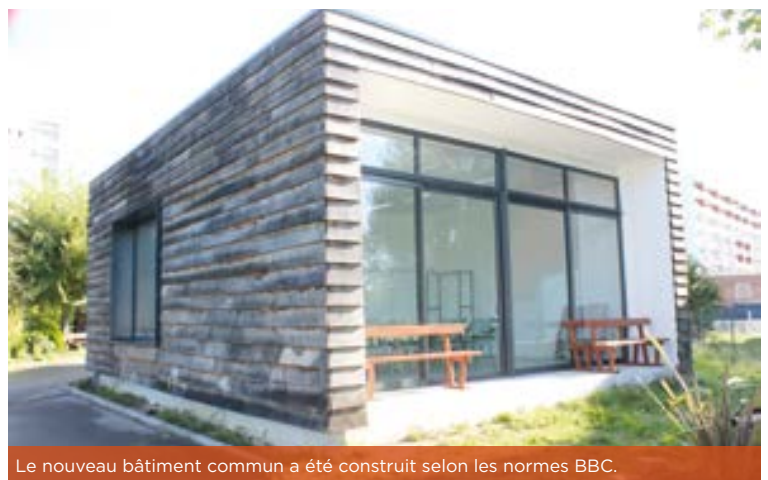
Le nouveau bâtiment commun a été construit selon les normes BBC.
