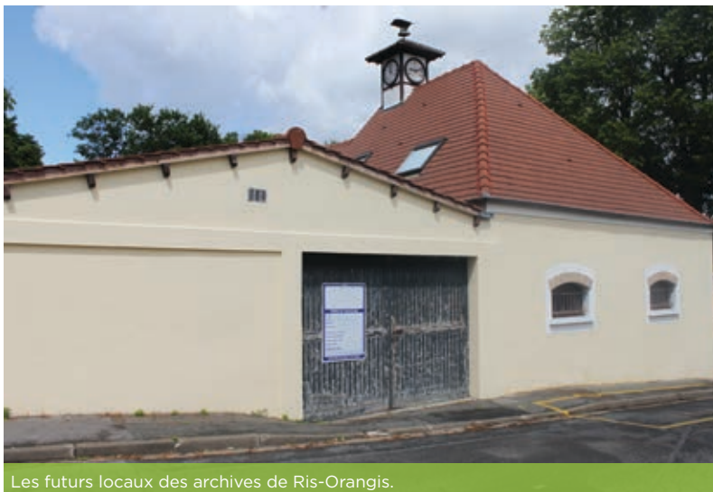
Les futurs locaux des archives de Ris-Orangis.
