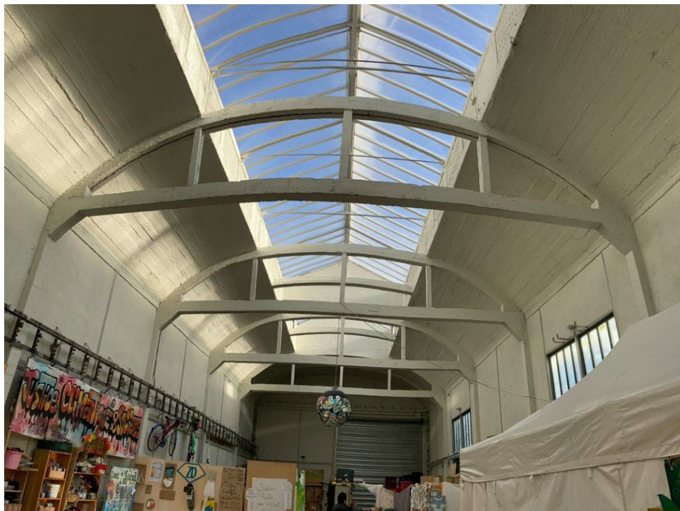
Toiture intérieure de la Halle
