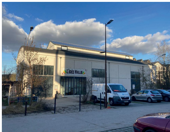
Façade Ouest du bâtiment
