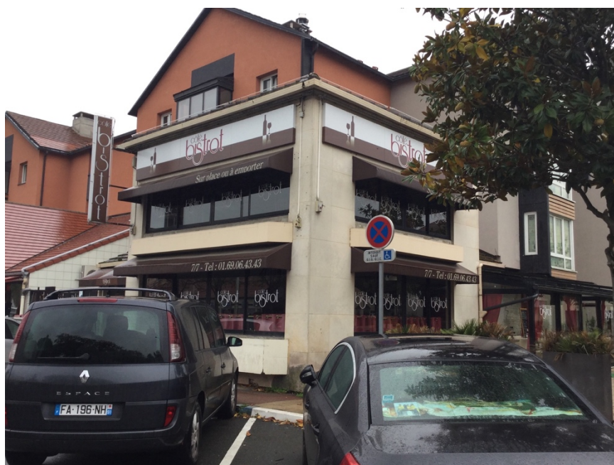
Enseignes parallèles au mur installées en étage sur un bâtiment n'accueillant qu'une seule activité (redondance du message), Ris-Orangis, octobre 2019.
