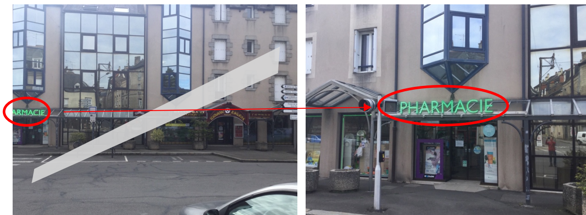
Exemple d'enseigne sur auvent ou marquise (non relevé sur Ris-Orangis).
