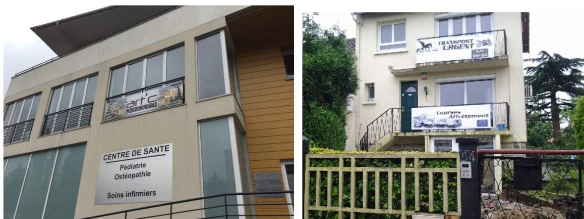
Enseignes sur garde-corps de balcon, masquant l'architecture du bâtiment, Ris-Orangis, octobre 2019.
