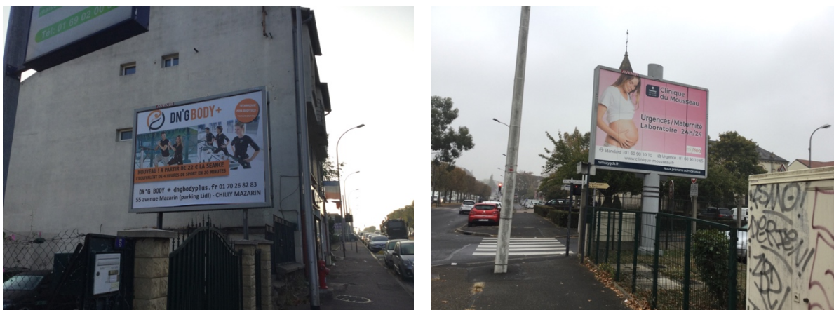
Publicités scellées au sol ou installées directement sur le sol sur 2 pieds et mono-pieds, Ris-Orangis, octobre 2019.
