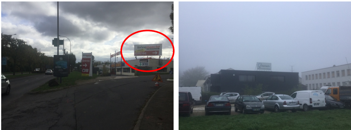
Enseignes sur toiture réalisées au moyen de panneaux de fond, Ris-Orangis, octobre 2019.
