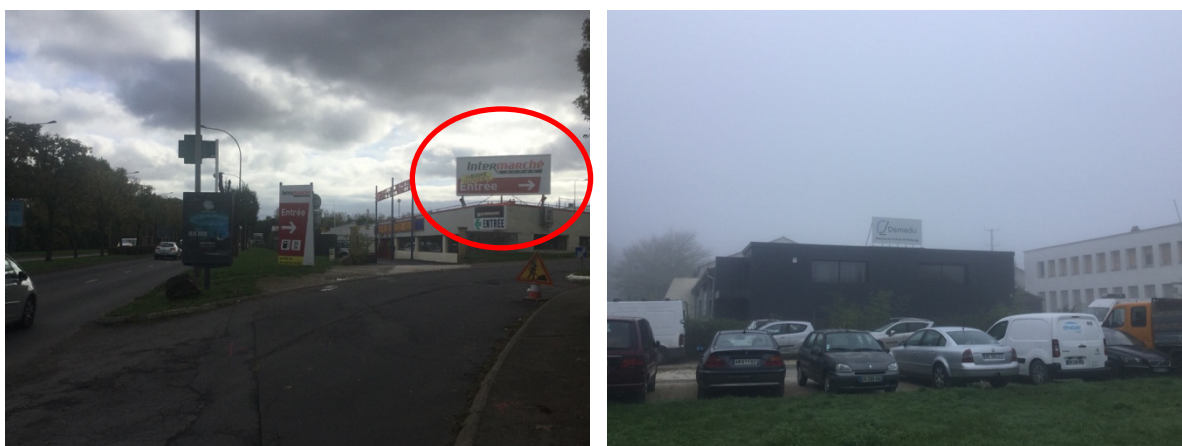
Enseignes sur toiture réalisées au moyen de panneaux de fond, Ris-Orangis, octobre 2019.
